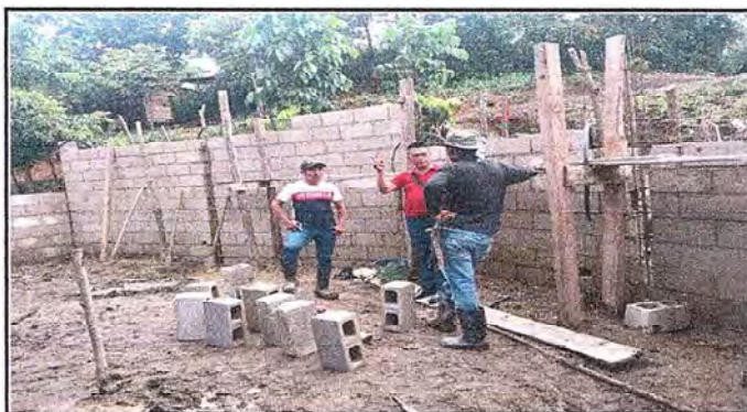
Foto 4: SUSTITUCION DE PARED DE AULAS
