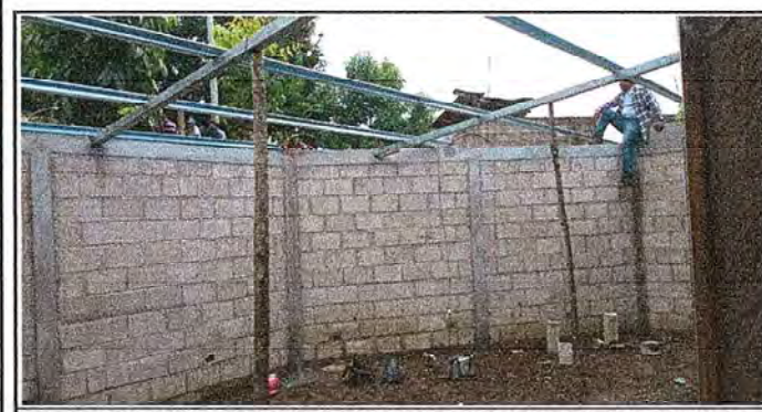
Foto 5: SUSTITUCION DE CUBIERTA DE LAMINAS DE AULA DE TERCER GRADO SECCIÓN "B"
