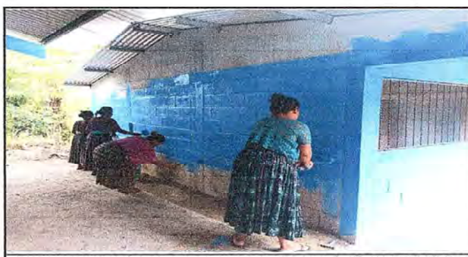
Foto 6: SUSTITUCION DE PINTURA DE PAREDES DEL ESTABLECIMIENTO
