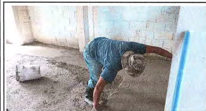
Foto 3: SUSTITUCION DE PISO DE AULA DE TECNOLOGIA
