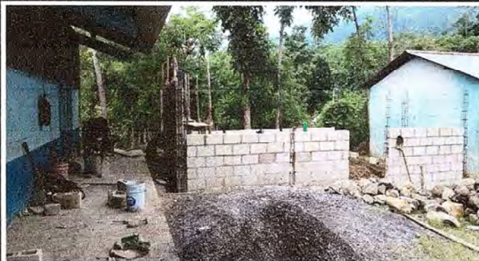
Foto1: SUSTITUCION DE PAREDES DE DOS AUAS
