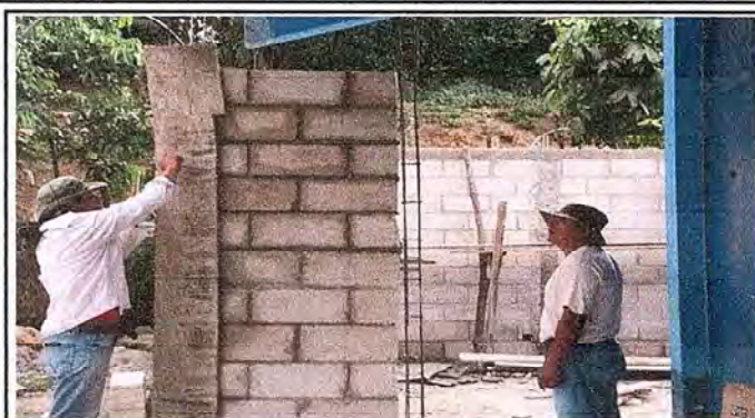
Foto 2: SUSTITUCION DE PARED DE AULA
